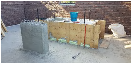
Bekisting gemaakt in eigen beheer + storten beton voor motorblok
